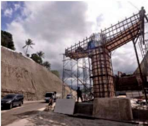
Proyek jalan tol Manado-Bitung di Manado, Sulawesi Utara, 2 Maret lalu.
